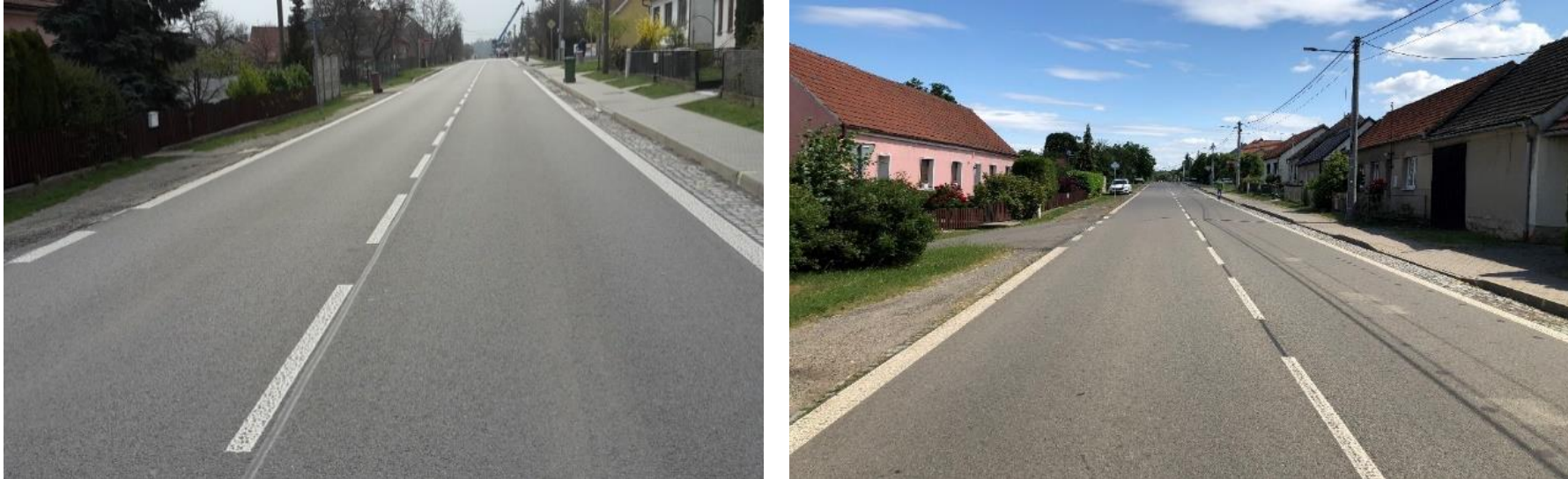
Stav vozovky po 4 letech (vlevo) a 8 letech (vpravo) v obci Domašov (II/602)
