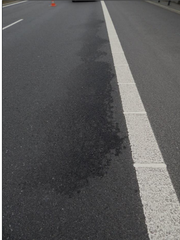
Ukázka nadměrné separace rozpouštědlovým separátorem při pokládce
