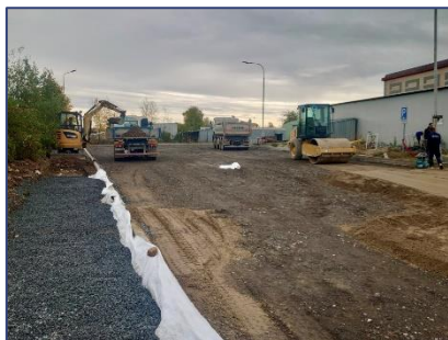
Škvára z Teplárny ZEVO Malešice v podloží parkoviště
