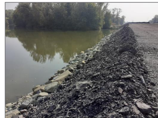
Násyp silnice I/67 v Karviné (2021)
