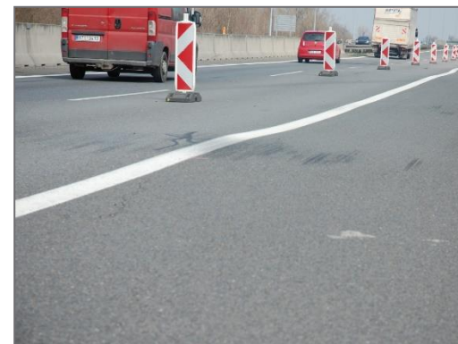
Dočasná oprava vozovky na dálnici D47 (2019)
