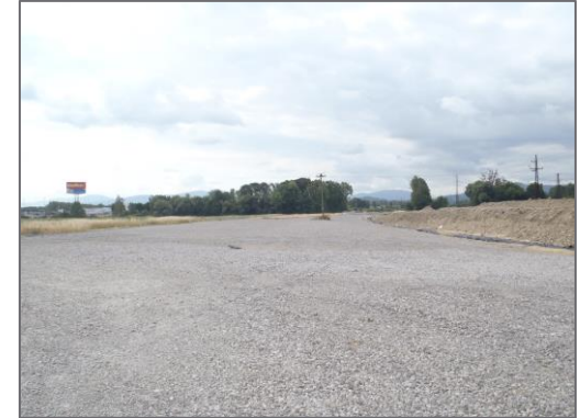
D56 – připojení na D48 (u FM) - použití vysokopecní strusky z AMO v sanační vrstvě po 10 letech zákazu (2019-2021)
