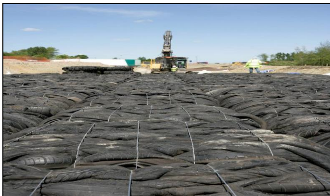
Balíky pneumatik ve vylehčeném násypu silnice A421 ve Velké Británii (foto A. Kidd, 2008)
