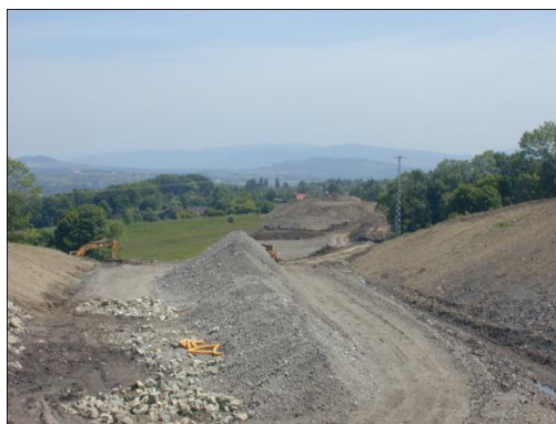
Vysokopeční struska z odvalu TŽ Třinec připravená na stavbě “Silnice I/48 Tošanovice – Žukov” (2006)
