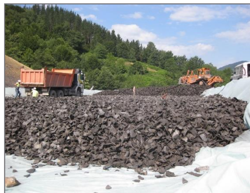
Drcené pneumatiky v jádru násypu, Pedrizas, Malaga, Španělsko (foto A. Parilla, 2018)
