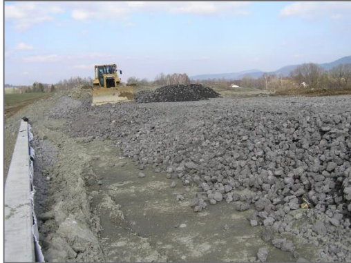
Silnice I/11 Jablunkov - obchvat - použití vysokopecní strusky z TŽ Třinec v aktivní zóně (2006)
