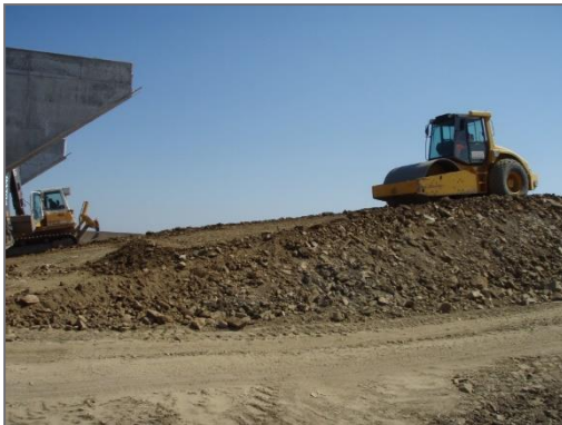
Výstavba násypu z lomové skrývky (lom Kajlovec 0/300) – Opava – spojka S1 (2010)
