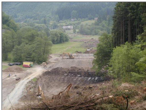
Materiál z ražby tunelu Malá Huba použitý do nově budovaného násypu železniční trati (06/2004)
