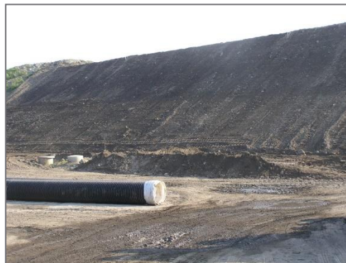
Dálnice D47 - násyp v km 3,120 MÚK Místecká (uhelná hlušinová sypanina z odvalu Paskov D)
