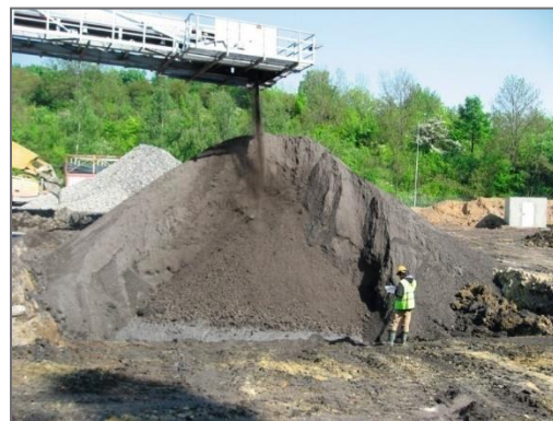
Materiál z ražeb tunelů metodou TBM (metro, trasa A, Motol), 2006
