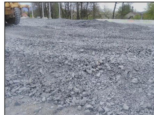
Zabudování jílovitých břidlic z lomu Jakubčovice n. Odrou do násypu na stavbě D48 Frýdek-Místek, obchvat, 1.etapa (05/2021)
