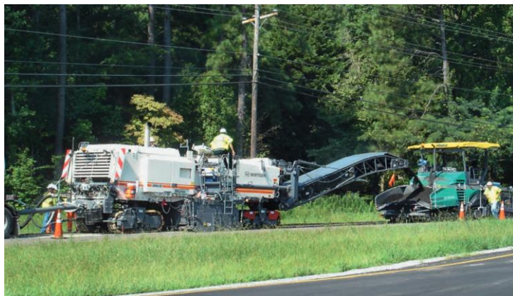
Realizace vrstvy RS CA na místě finišerem
