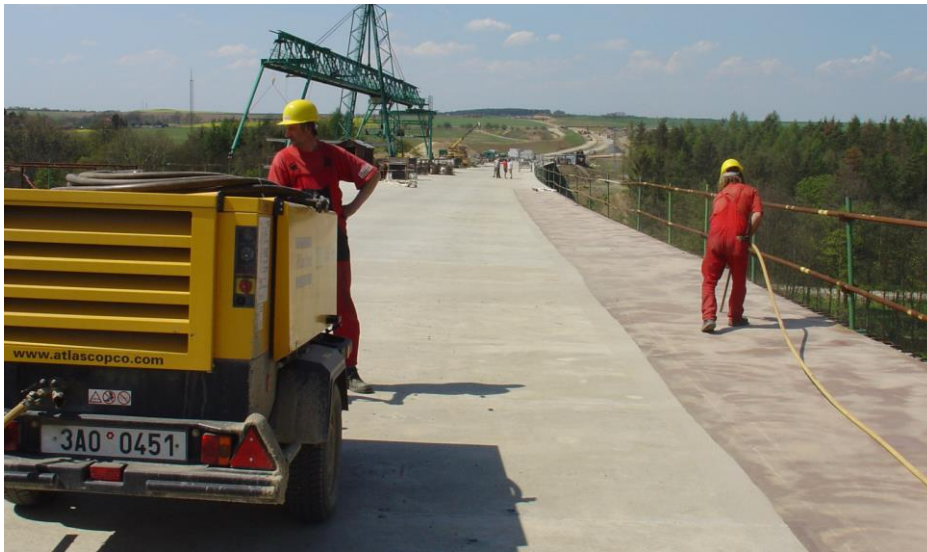
čištění povrchu primární vrstvy tlakový vzduchem
