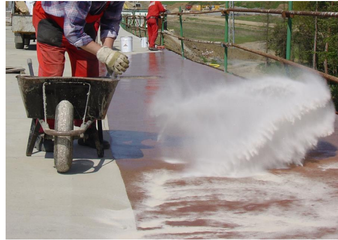
čištění povrchu primární vrstvy tlakový vzduchem
