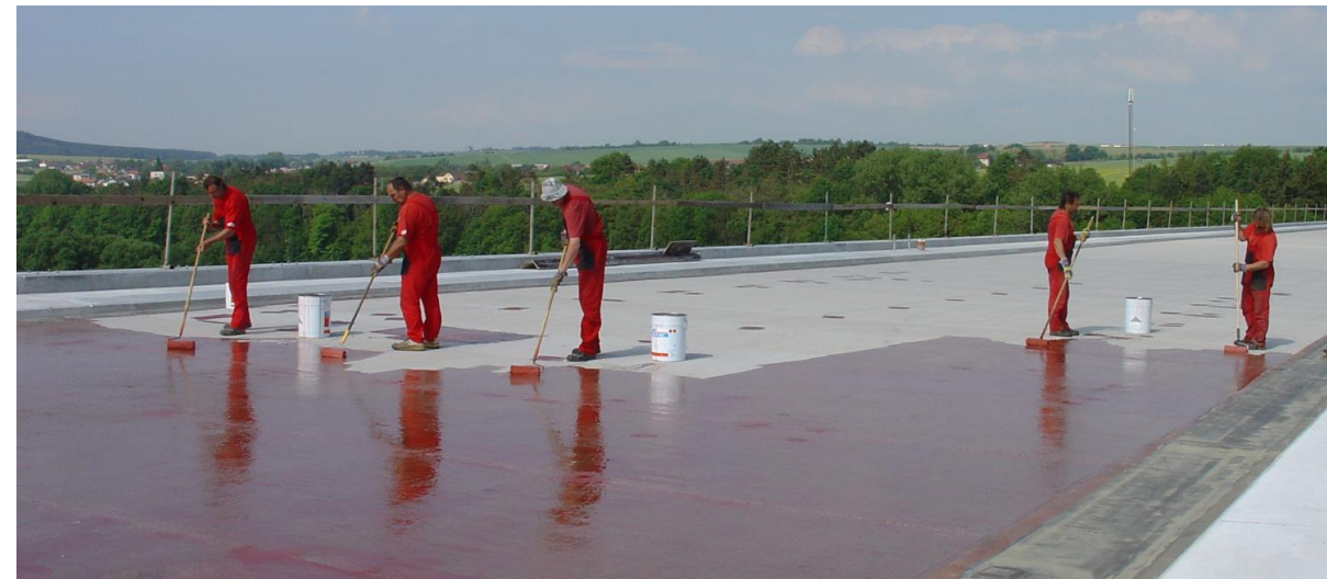
realizace primární vrstvy s posypem křemičitým pískem
