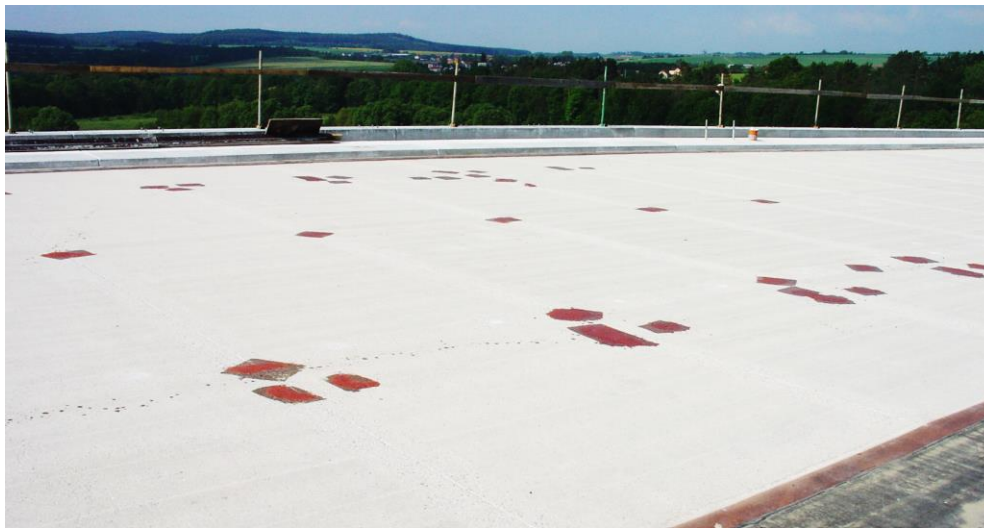
provádění lokálních výsprav
