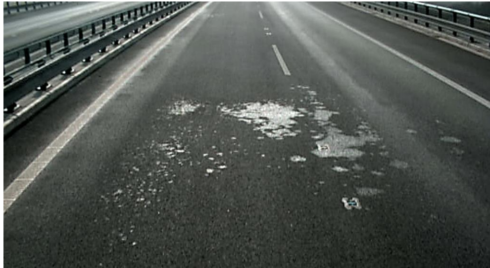
Výrony vody z obrusné vrstvy
