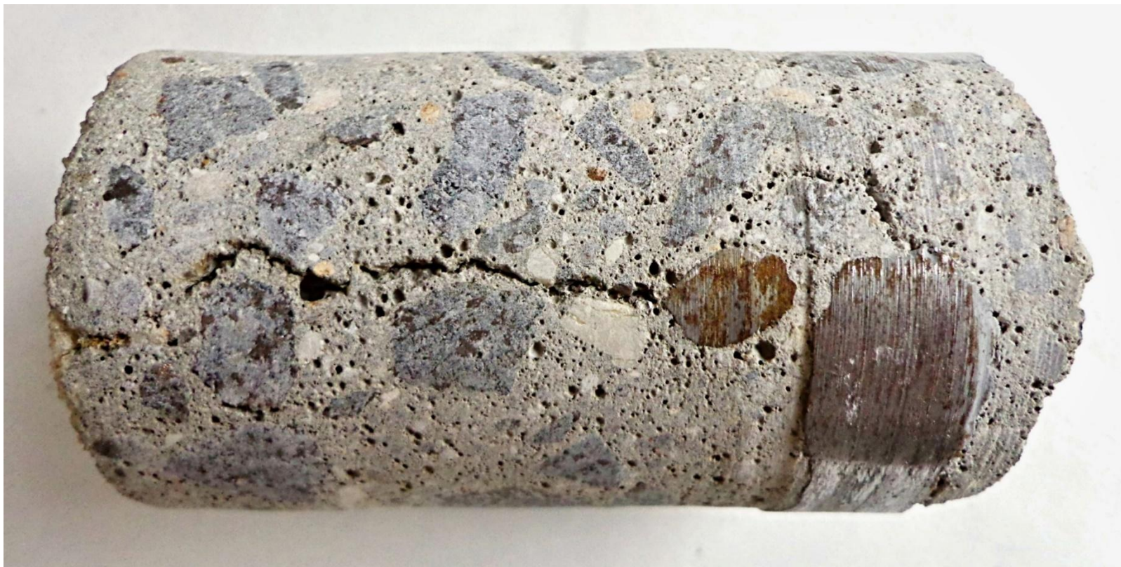
Zde vidíme, že trhlina je nezainjektovaná, pouze na povrchu je překrytá epoxidem PV a jím slepeným pískem
