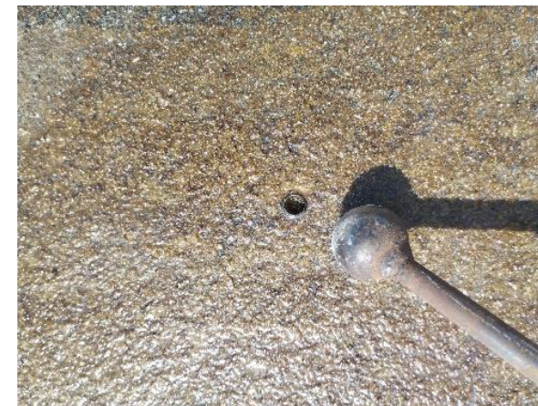
Vzduchové kanálky v primární vrstvě. Zdroj: Vlastní.. 9
