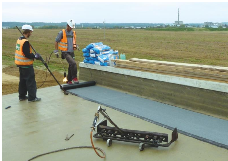
Natavování AP pomocí jednoduchého hořáku. Zdroj: Vlastní..
