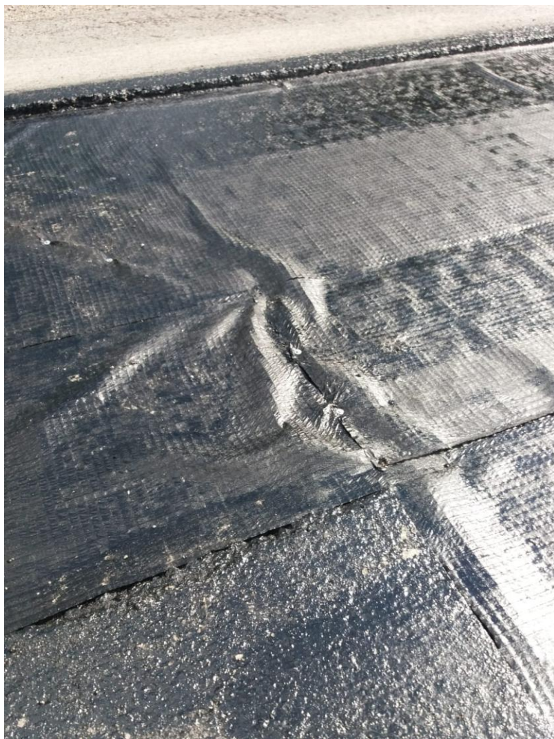
Chyby při instalaci
